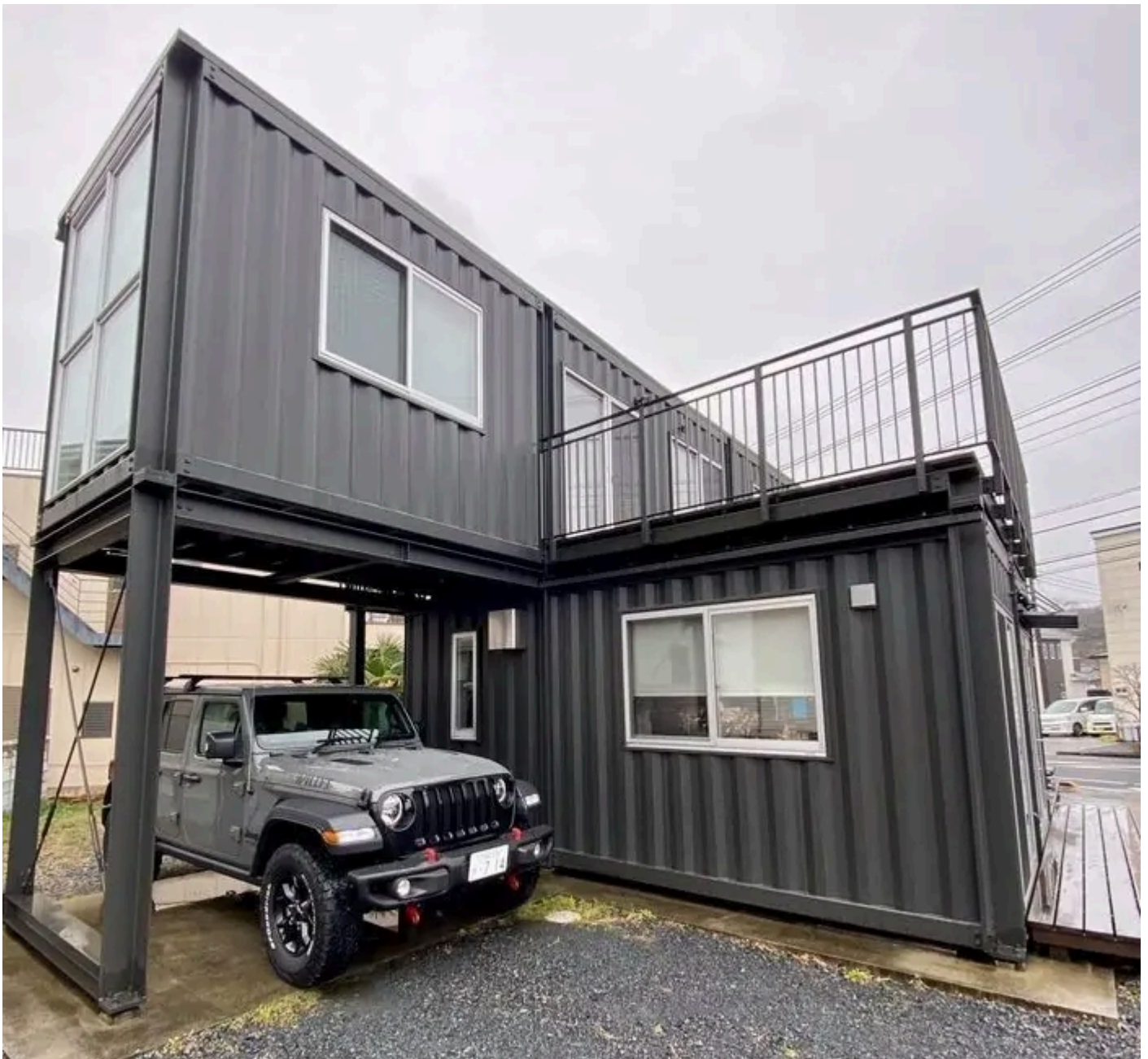
یکی از طرح‌های اجرا شده از خانه کانتینری
